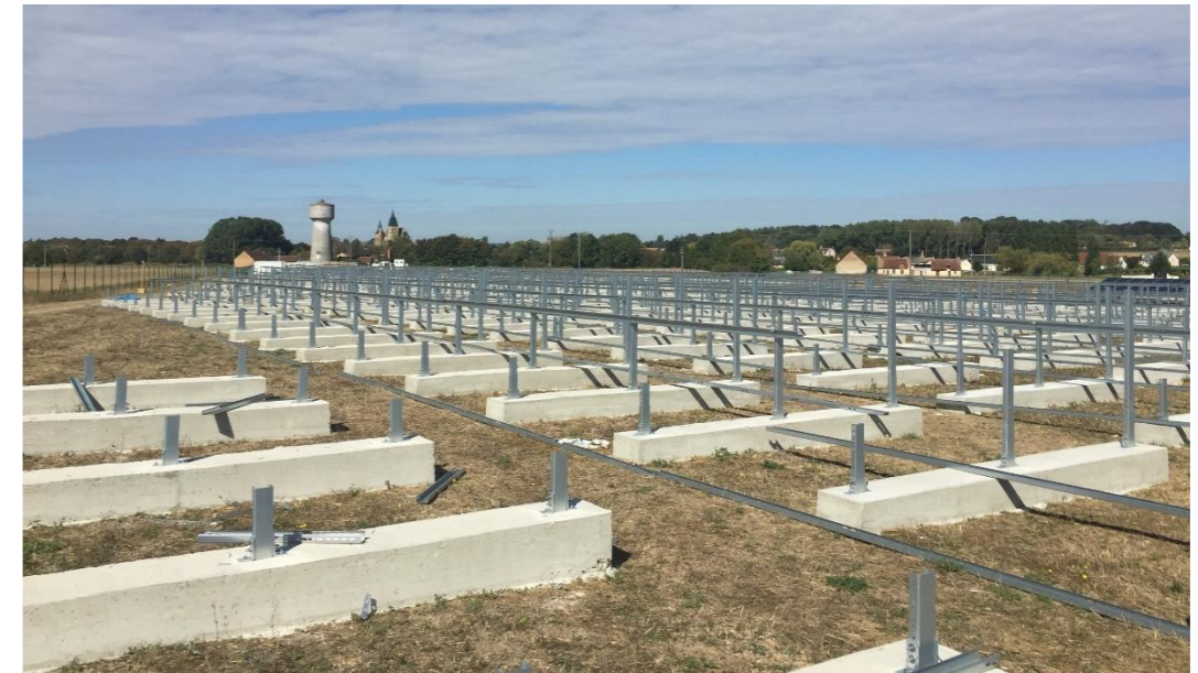
Installation des structures photovoltaïques sur les longrines bétons
