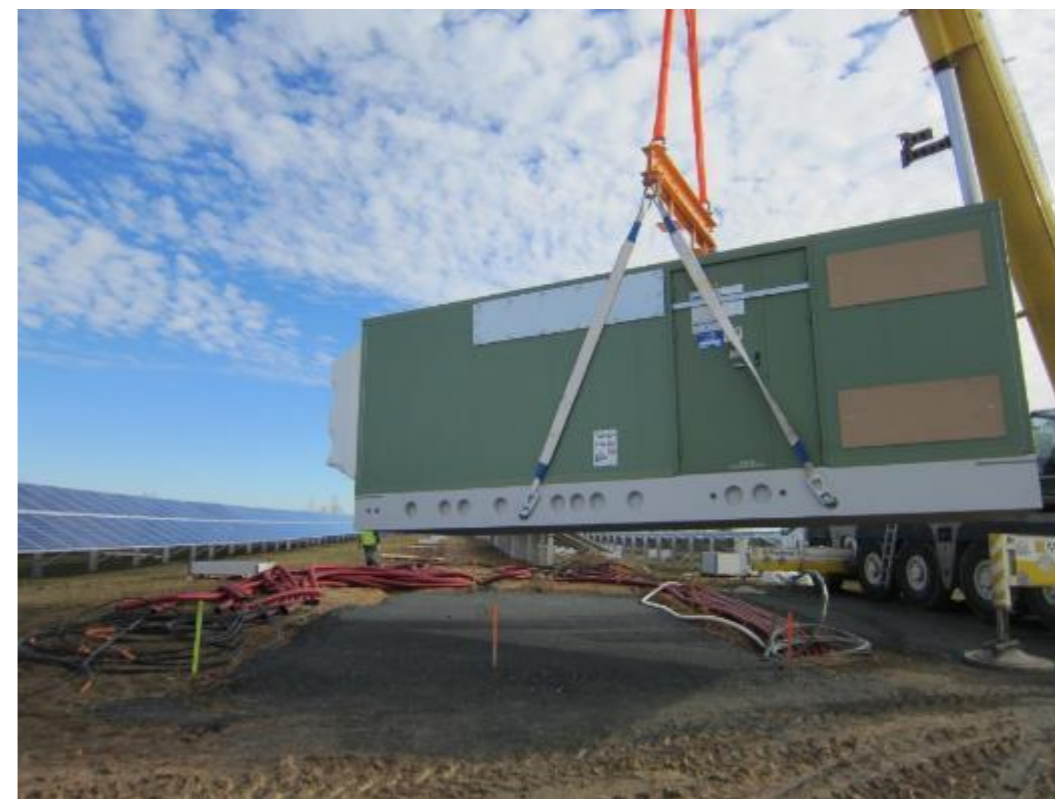
Illustration 30: Exemple d'installation de poste de transformation (Neoen)
