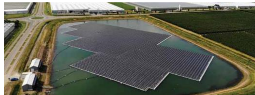
Illustration 43: Exemple de centrale avec les câbles flottants (Neoen)
