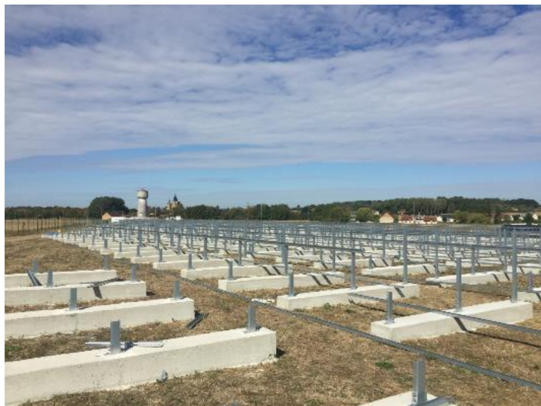
Illustration 26: Exemple d'ancrage sur longrines béton (Neoen)
