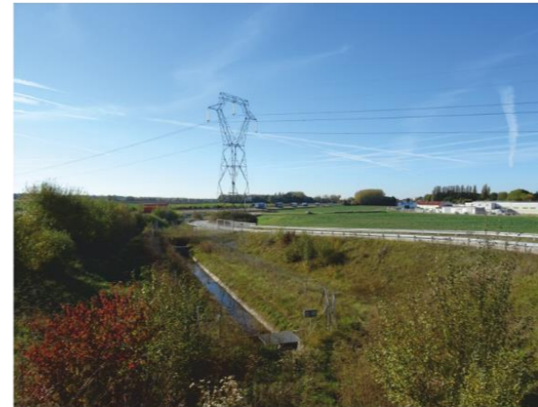
19 - Route nationale N4 et ligne électrique aérienne à Haute Tension
