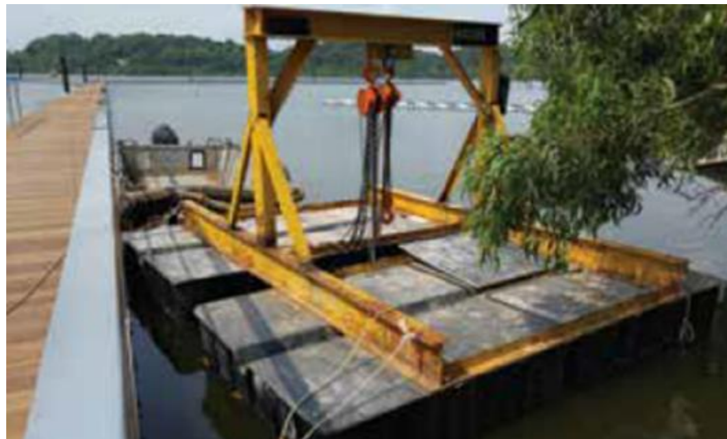
Illustration 49: Exemples de barge d'installation de corps morts (Neoen)
