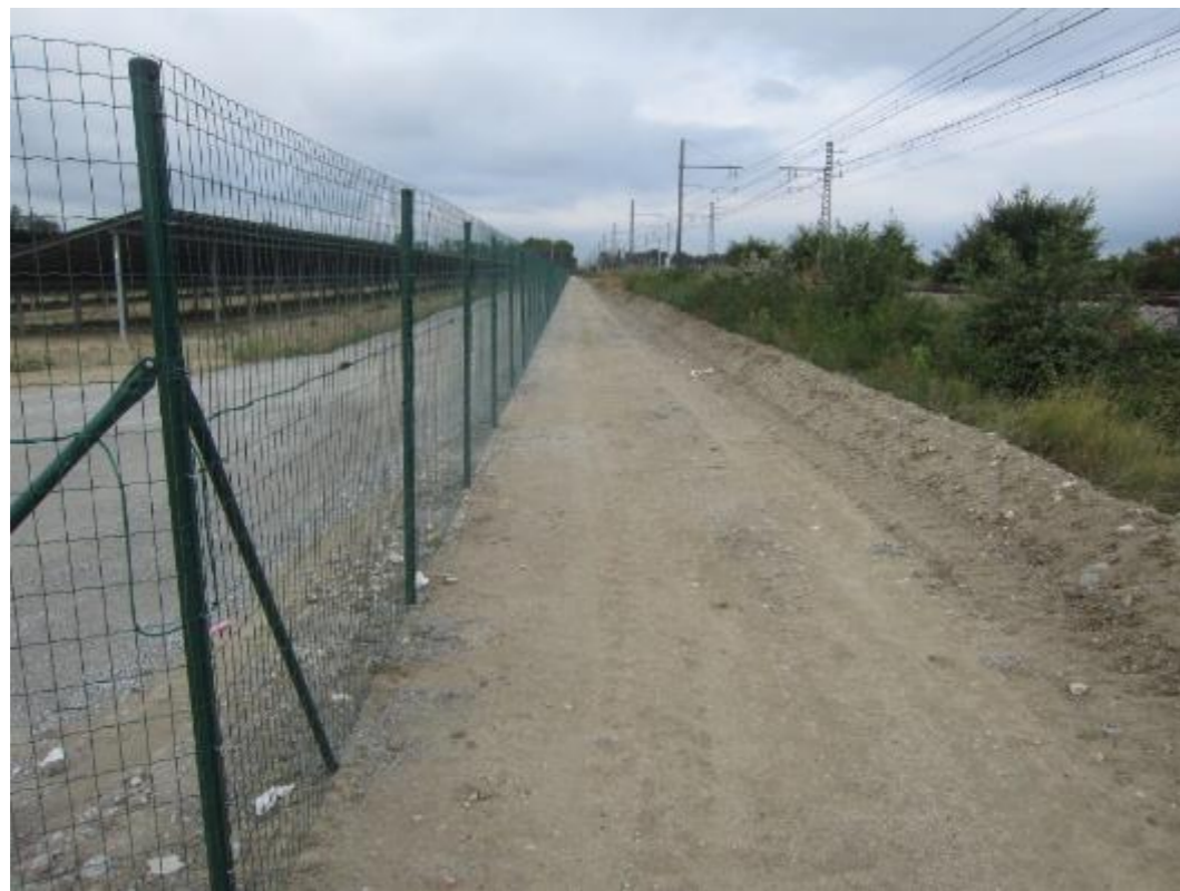
Illustration 59: Exemple de clôture et pistes (Neoen)
