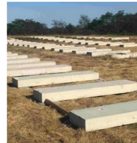
Illustration 48: Exemples de structures sur longrines béton (Neoen)
