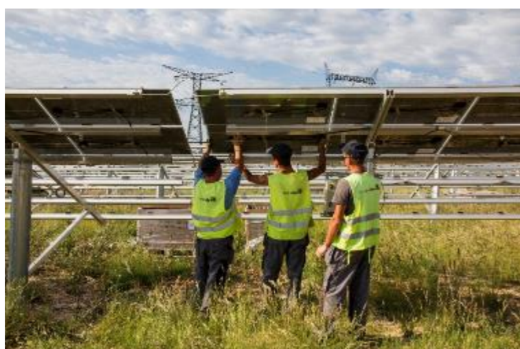
Illustration 53: Exemples de pose de modules (Neoen)
