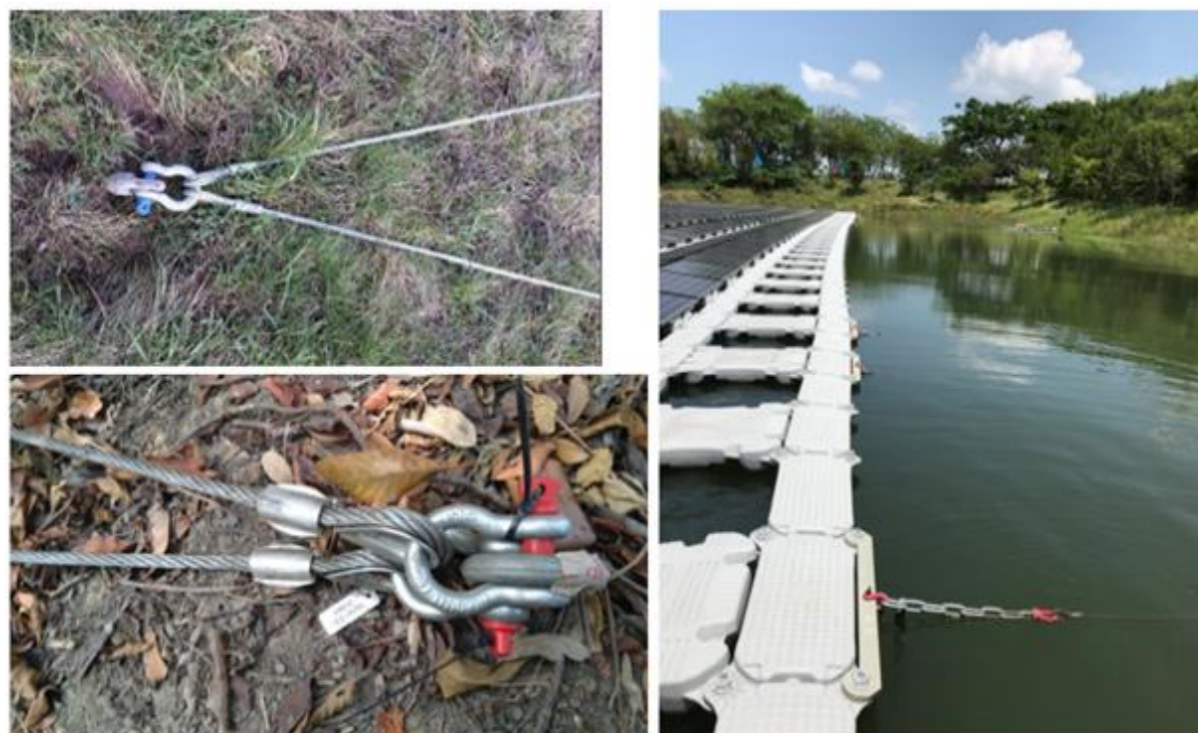
Illustration 41: Ancre à bascule (Platinus Earth System)
