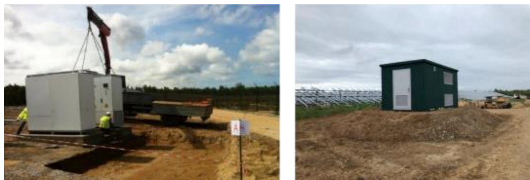
Illustration 56: Installations des postes de transformations (à gauche pour avec la méthode classique avec affouillement et à droite la méthode hors-sol avec un poste surélevé) - (Neoen)
