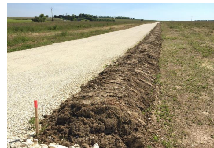
Illustration 80 : Exemple de piste légère sans décaissement avec merlon latéral
