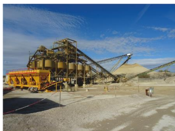
18 - Carrière SA MORONI, à 800 m au sud-ouest de l'aire d'étude
