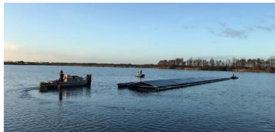
Illustration 55: Opérations sur le plan d'eau et connexion des flotteurs avec le système d'ancrage (Neoen)
