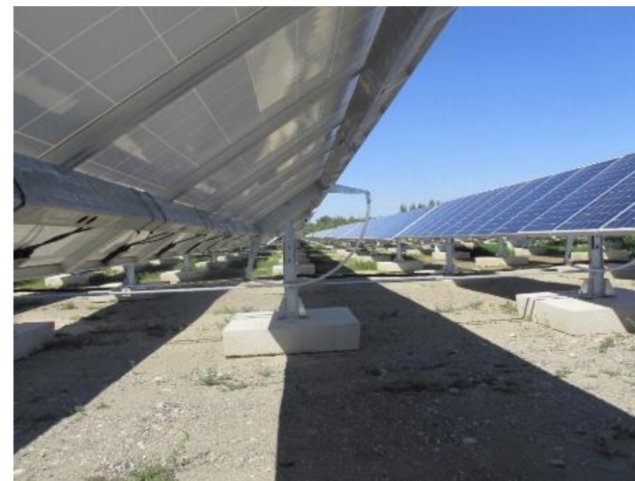
Illustration 24: Exemple d'ancrage sur plots bétons (Neoen)
