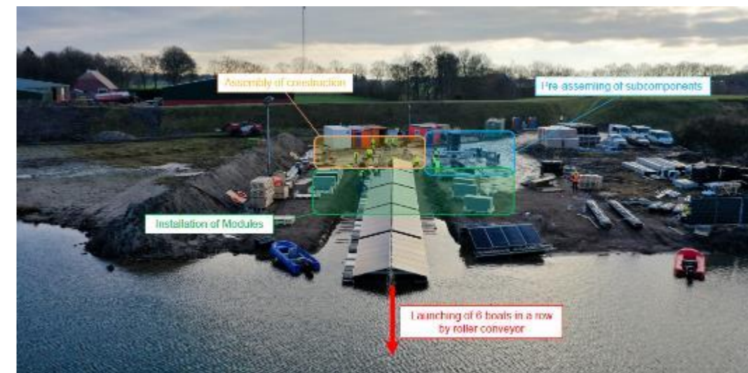
Illustration 61: Exemple de zone d'assemblage et lancement (Neoen)
