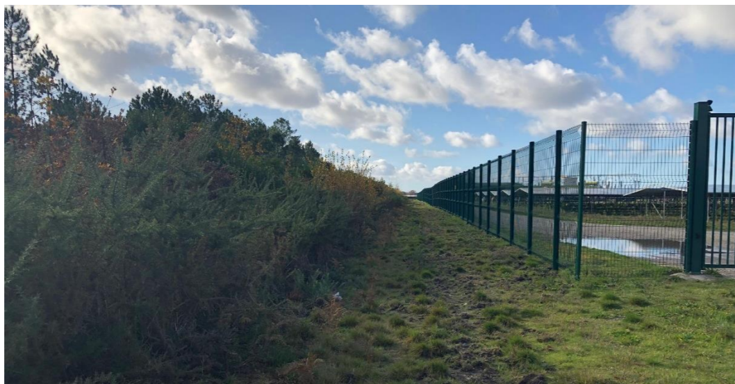
Illustration 86 : Exemple de clôture (source : NEOEN)
