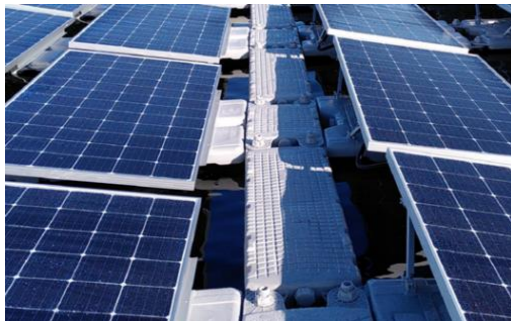
Illustration 33: Exemple de panneaux solaires sur structure type Ciel & Terre (Neoen)
