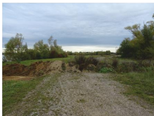
5 - Talus à l'entrée du sentier de terre entre les deux étangs SO et SE de l'aire d'étude
