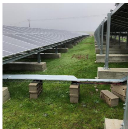
Illustration 83 : Exemple de câblages hors sol non intrusifs
