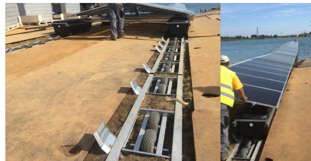
Illustration 66 : Protection de la berge par panneaux de bois sur les zones de lancement (source : NEOEN)
