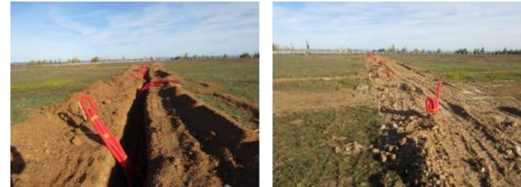
Illustration 57: Exemple de tranchée et pose de câbles dans des fourreaux (Neoen)
